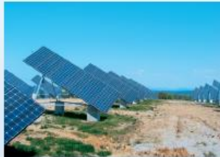
Ehemalige Mülldeponie mit 54 DEGER TOPtraker®, Deutschland.
