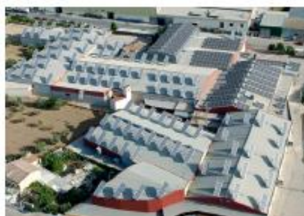
Dachanlage mit 120 DEGER TOPtraker, Spanien.
